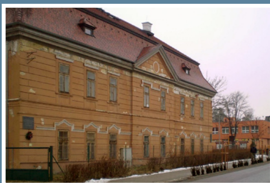
Stav budovy školy v L. Hrádku (r. 2011)
